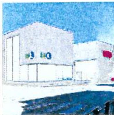
Il supermercato della Coop fra le vie Verdi, Garibaldi e Matteotti
